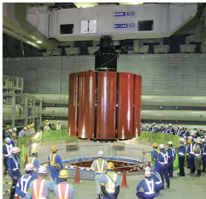
Rotor of 525-MVA/464-MW generator-motor
