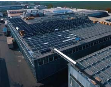
北米 送発電設備 (イメージ)
