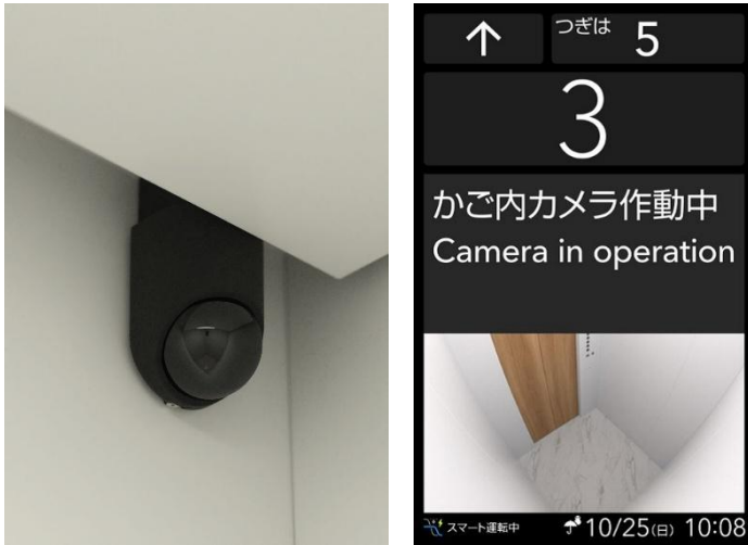
かが内カメラ(左)、かが内液晶表示(右)
