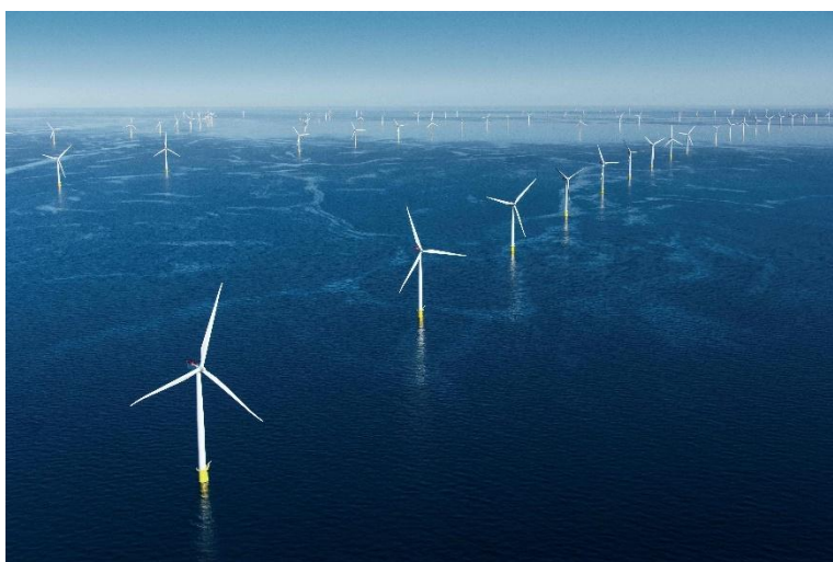
日立エナジー、オーステッドと洋上風力発電所における電気システムシステムで包括提携
