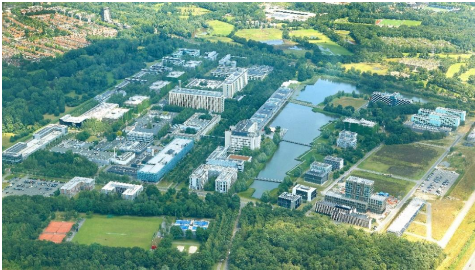
High Tech Campus Eindhoven の航空写真
