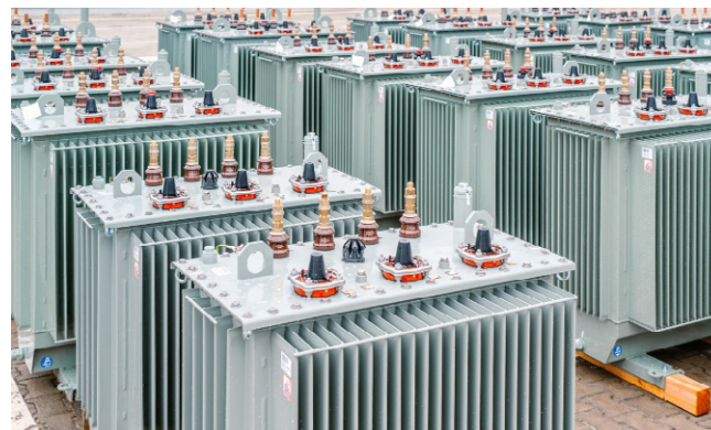
リサイクル鉱物油入り変圧器
